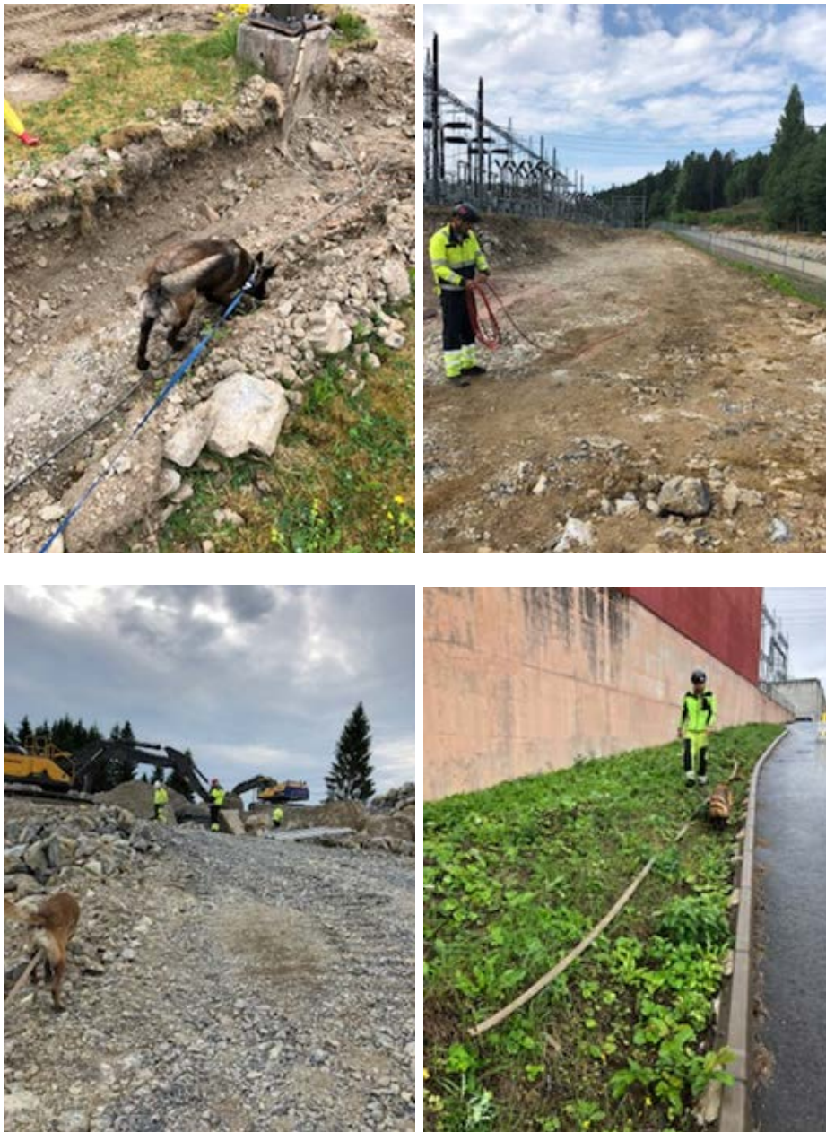
Figur 2.6 Søk ved transformatorstasjonen i Sylling.
