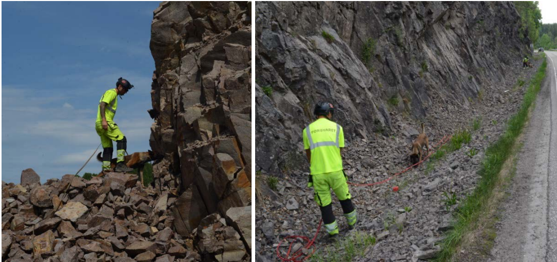
Figur 2.8 Søk på vegskjæringer i Vestfold.
