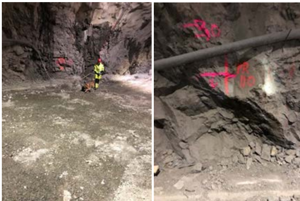
Figur 2.26 Kjørbotunnelen i Sandvika.
