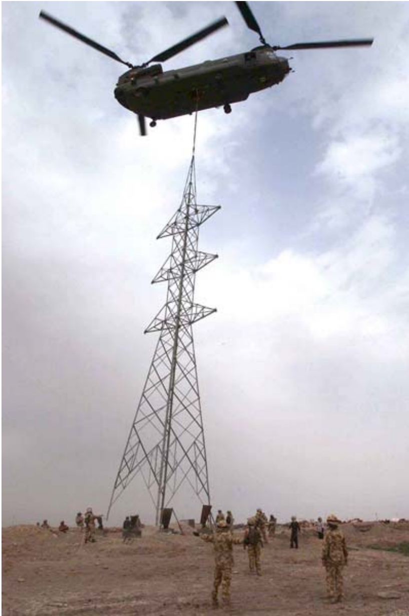
Figur 2.2 Britisk Chinook helikopter heiser opp en mast under gjenoppbygging av strømnettet i Sør-Irak. Bruk av kranbiler er vanskelig i sumpområdene i Sør-Irak (Bilde: UK MOD)
