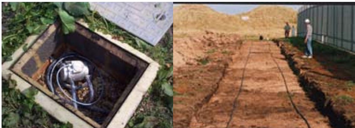
Figur 3.20 Kommersielt tilgjengelige trykksensor for perimeterovervåkning (Kilde: www.gpsperimeter.co.uk )
