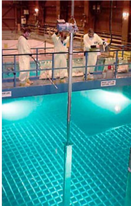
Figur 9.1 Våtlagring av brukt brensel ved et kjernekraftverk. Brenselselement med brukt brensel føres ned i kjølevannet. Foto: United States Government, offentlig eiendom.
